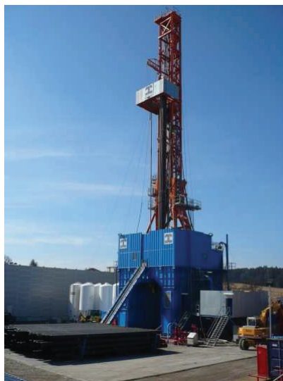
Abbildung 2: Tiefbohranlage Bentec Euro Rig 350t
